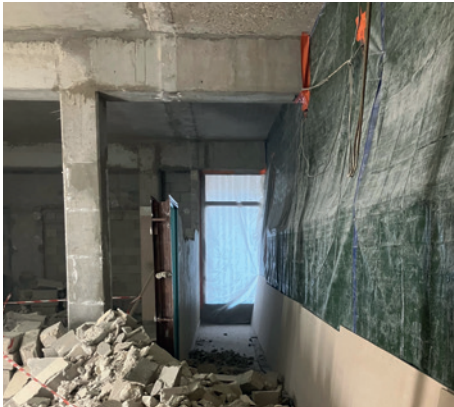
Dépose cloisons
