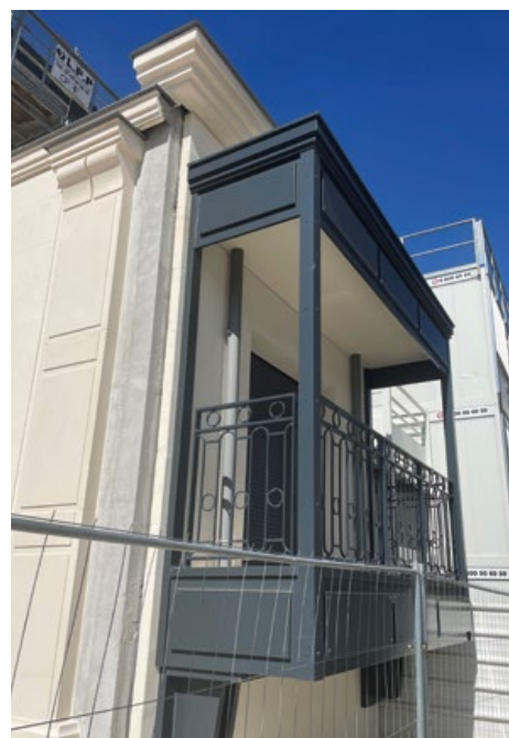
Bow-window : validation du support (corbeaux), de la teinte, des garde-corps, des descentes d'eaux pluviales.
