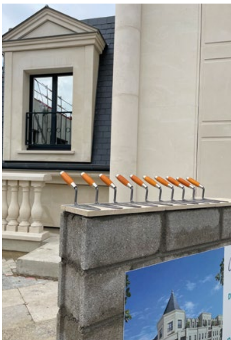
Fenêtre en lucarne : étude des corniches, du lien entre pierre, zinc et ardoise, validation du garde-corps.
