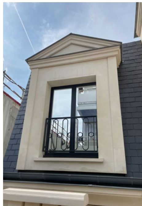
Fenêtre en lucarne : étude des corniches, du lien entre pierre, zinc et ardoise, validation du garde-corps.
